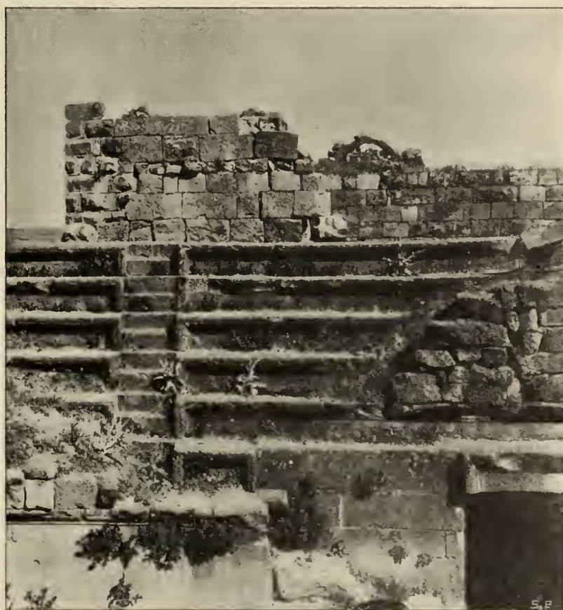
Fig. 973. Bosrâ: Theater: Ansicht der Sitzreihentreppe 12 (Tafel L) der Ostseite mit der links verdeckten Zugangstreppe. Rechts das Vomitorium 11.
