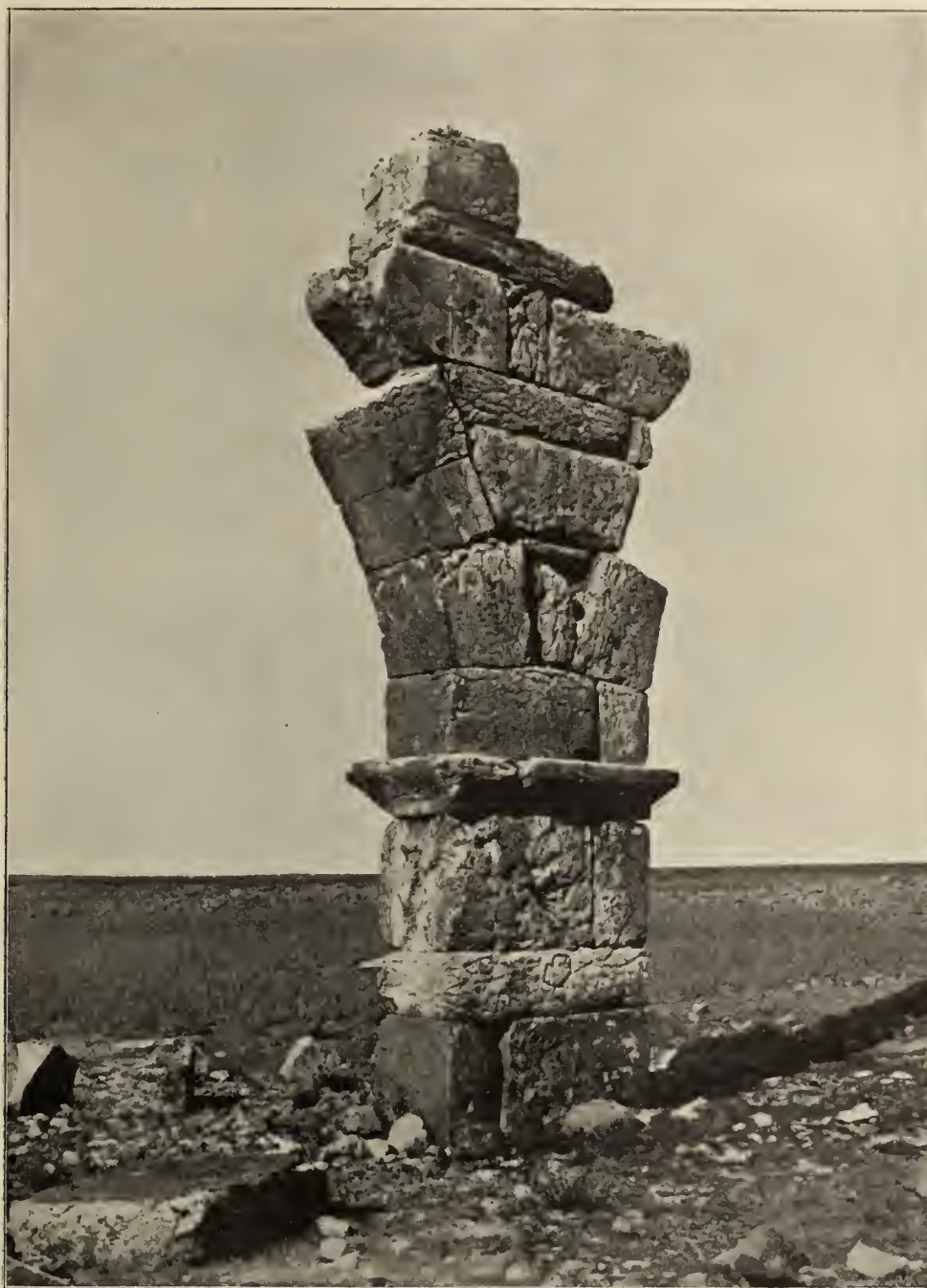
Fig. 1094. eḏ-Dumêr: Kastell: Pfeiler des Aquädukts (s. S. 195).
