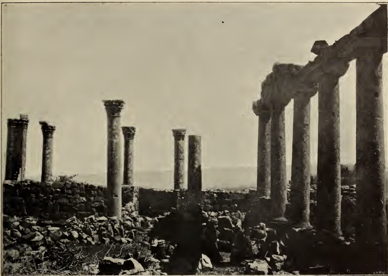
Fig. 1021. el-Qanawât: es-Serai: Blick von der Türe a im Atrium A nach Norden. Im Hintergrund links die östliche Ante des Pronaos C , rechts davon drei Säulen der Porticus des Atriums; im Vordergrund in der Mitte zwei Säulen der vorderen und rechts fünf Säulen der östlichen Säulenreihe des Atriums.
