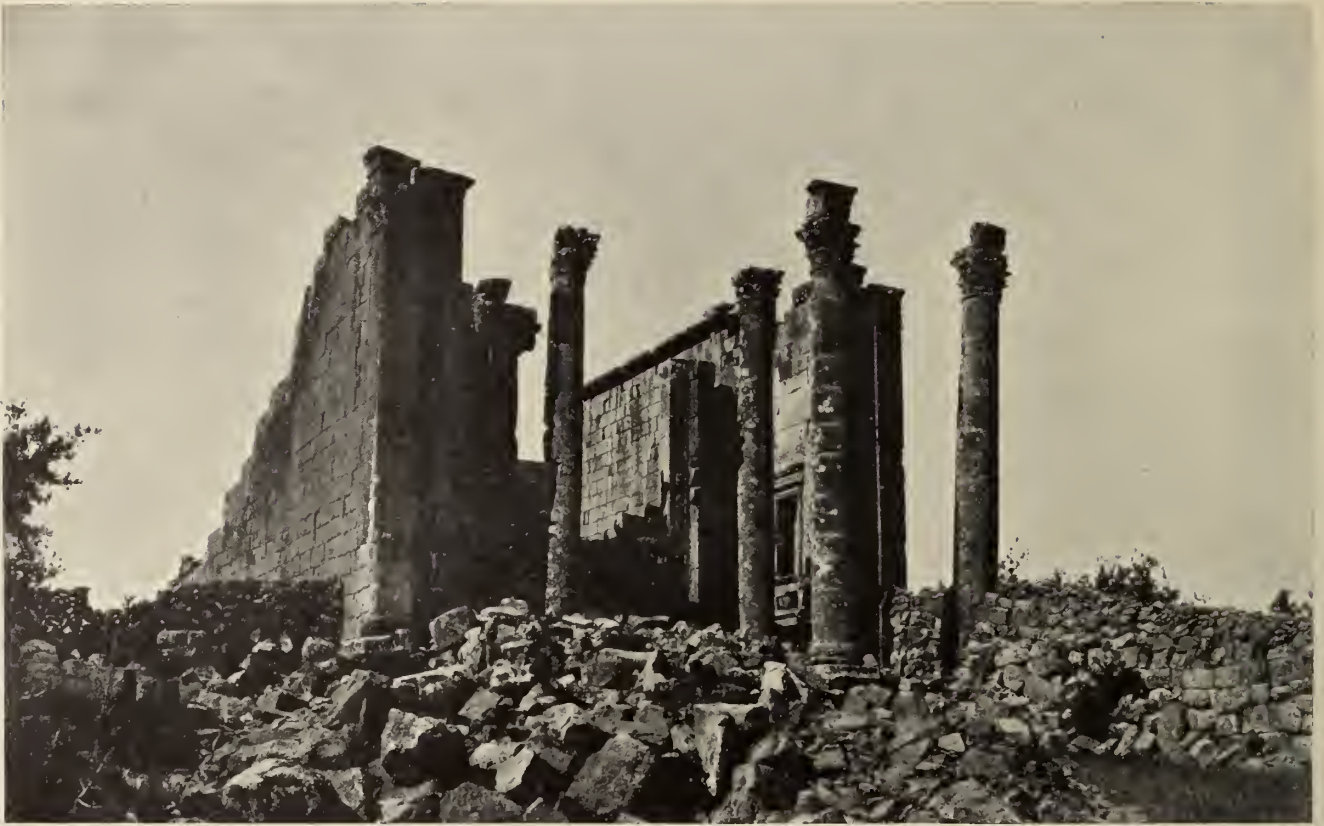
Fig. 1029. el-Ḳanawât: Prostylos: Ansicht von Nordosten.
