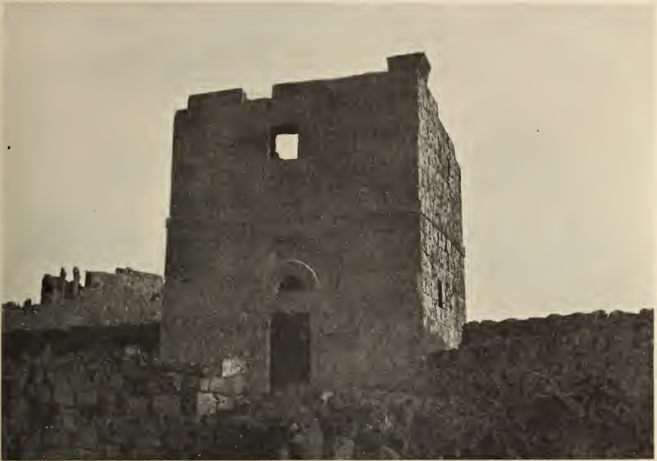
Fig. 1034. el-Ḳanawāt: Grabturm im Westen des Südwesttores: Ansicht von Norden. Im Hintergrund links der Prostylos-Tempel (No. 9) und die Stadtmauer.
