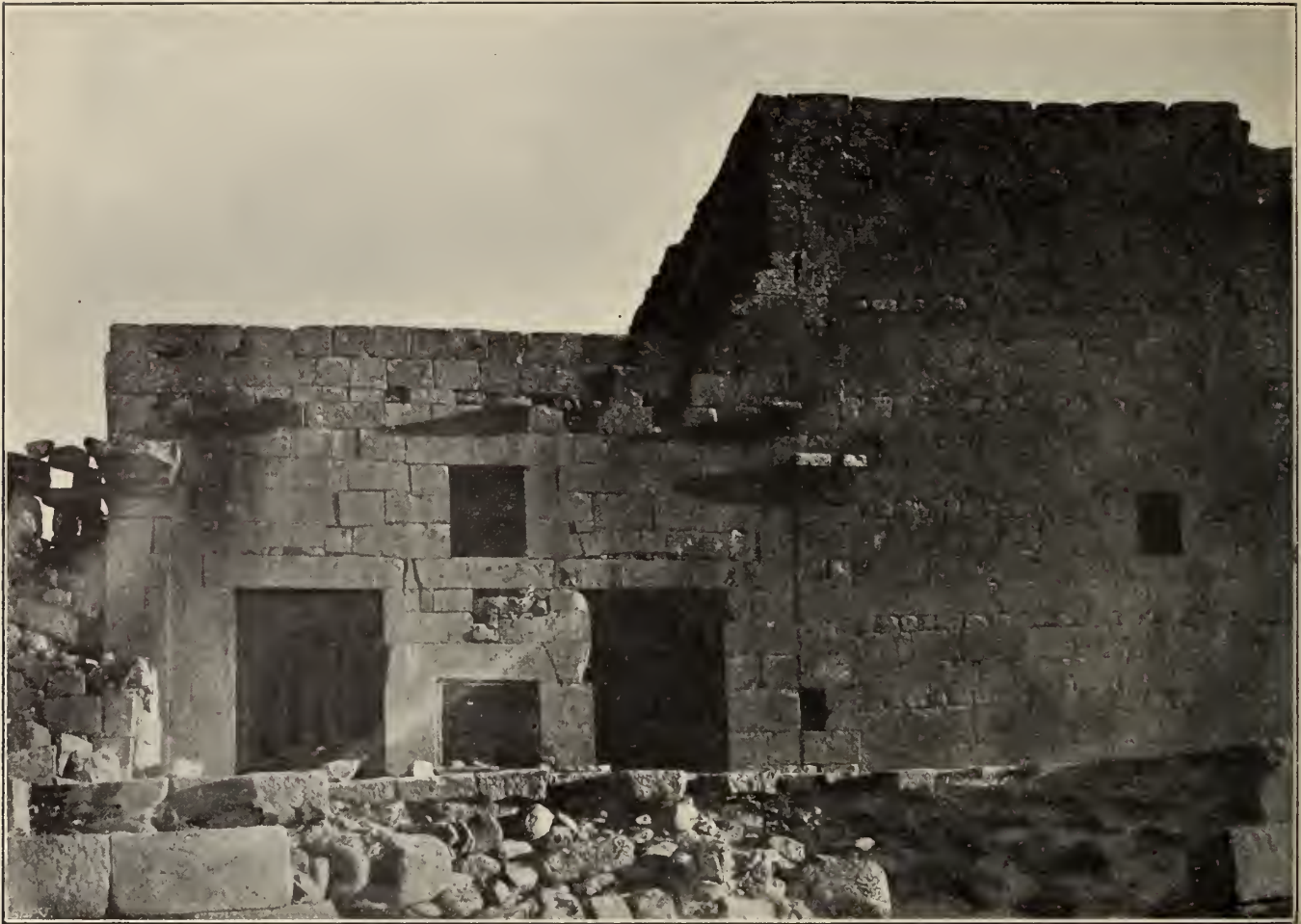
Fig. 1011. el-Ḳanawât: el-Medrese: Fassade von Norden.
